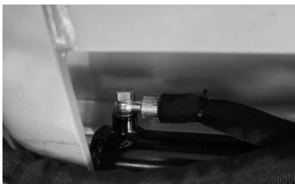
Fig. 16 Conduite hydraulique gauche
